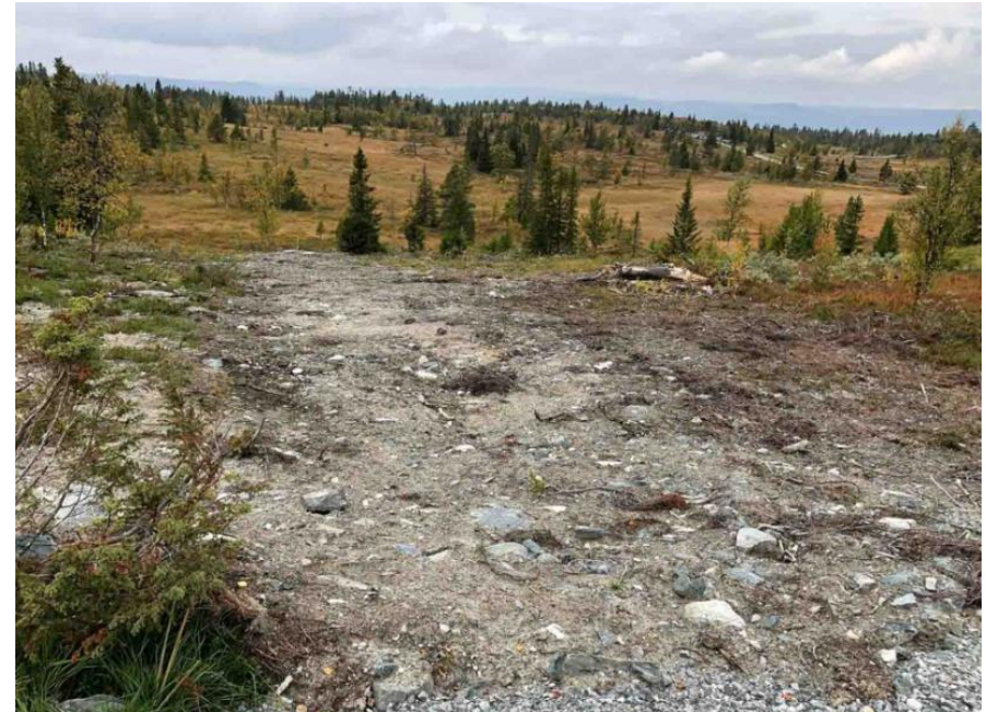
Grøft for vann og avløp – i 25 m bredde
